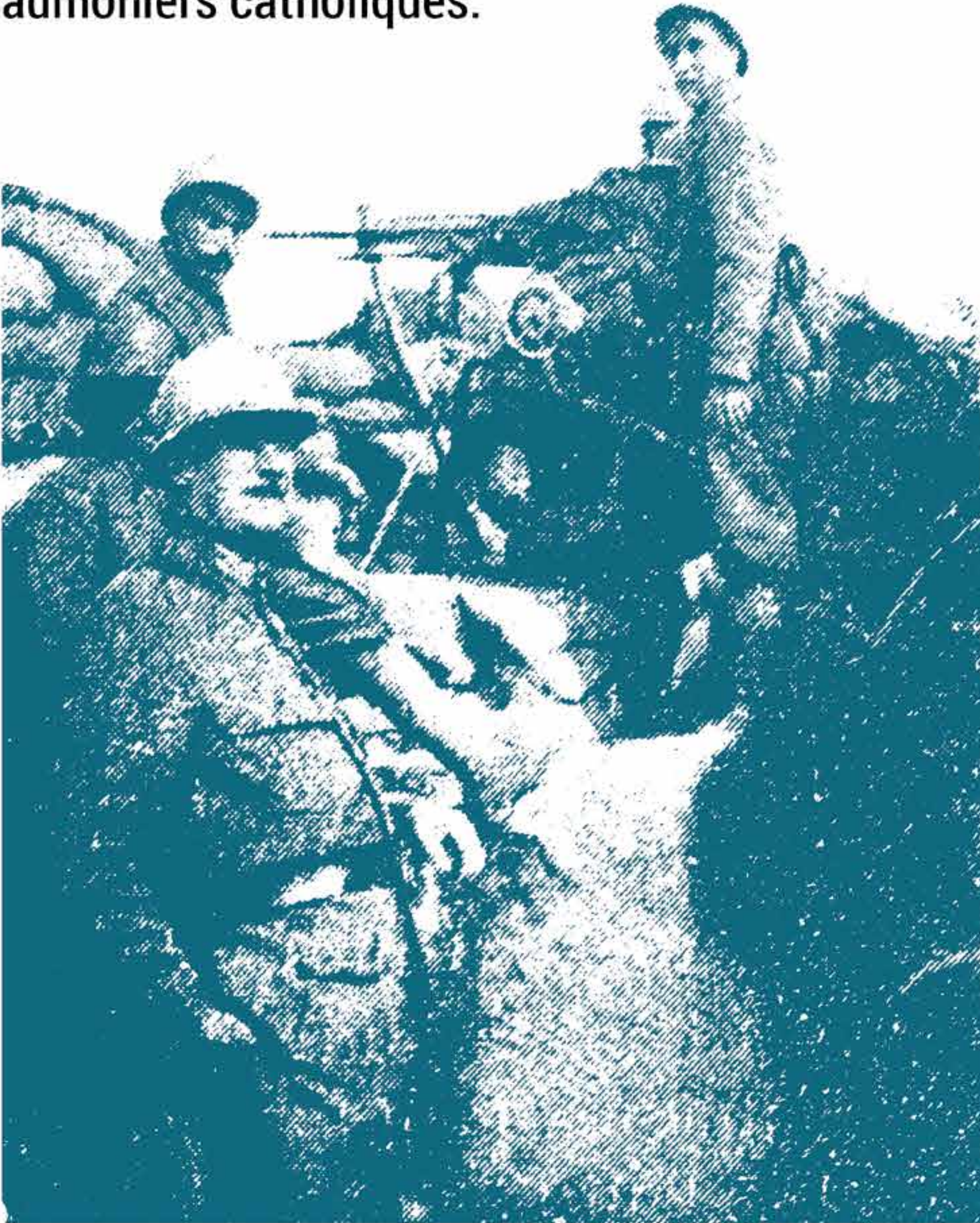
Pasteur Courtois dans la tranchée
